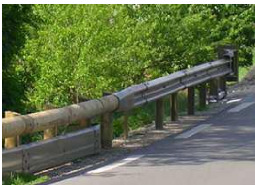
Transición elementos metálicos
