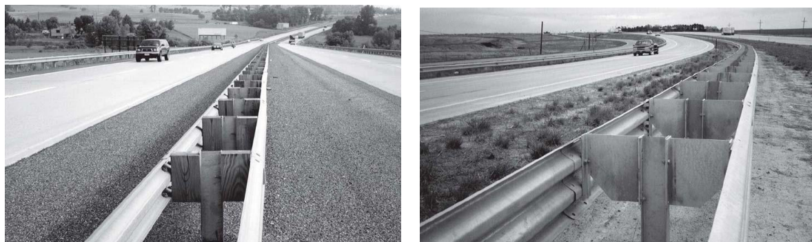
Barrera dobles faz con vigas doble y triple onda con separadores para mediana
