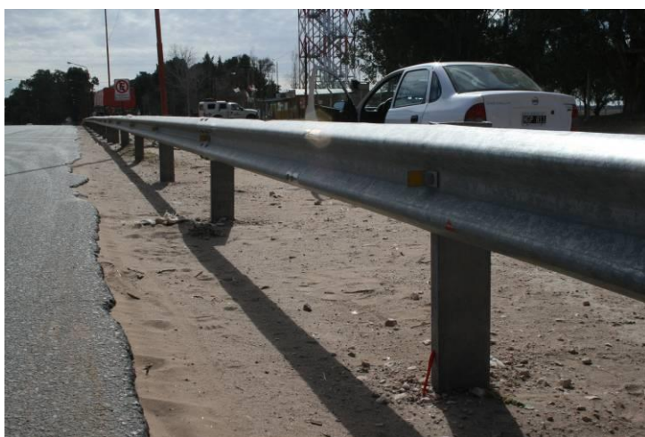
Instalación de barrera semirrígida lateral al camino
